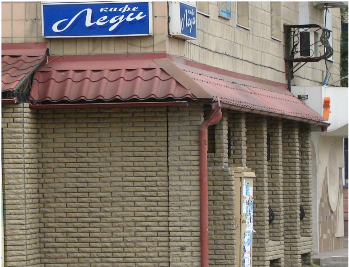
Рисунок 8 — Облицовка кирпичом завода «Фагот», 2000-е гг.
